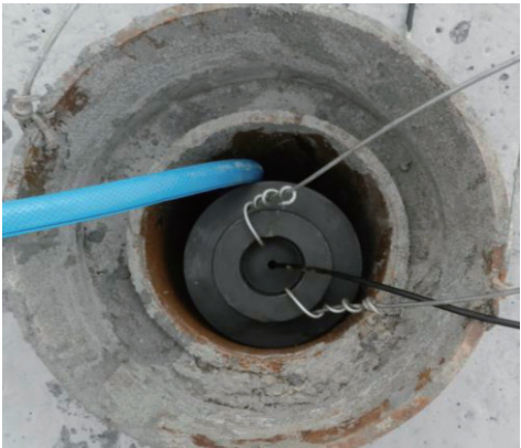
b. 环靶射孔试验现场安装图 图 6 环靶射孔试验安装图
